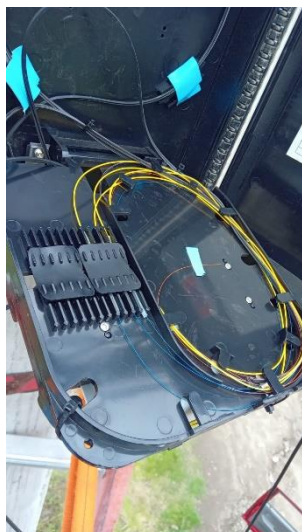
Imagen 10. Tubillo e hilos colocados debidamente dentro del splitter
