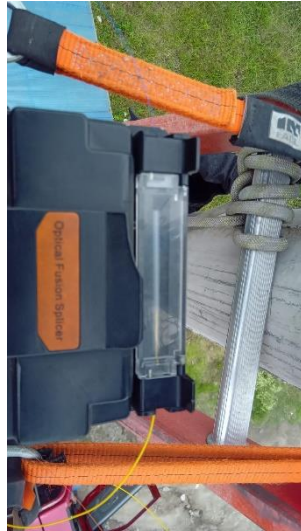
Imagen 9. Calentamiento de tubillo
