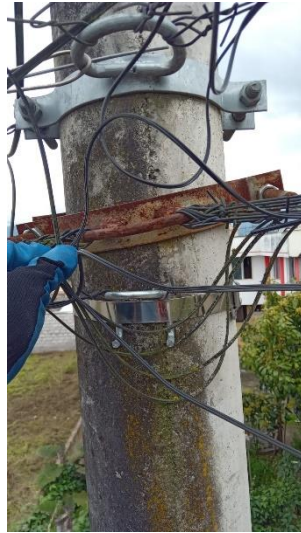
Imagen 12. Tendido de cable
