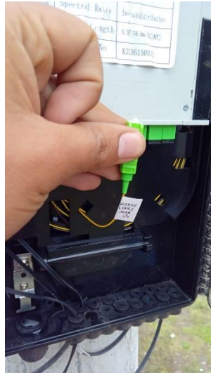
Imagen 6. Pigtail etiquetado con nombre de cliente
