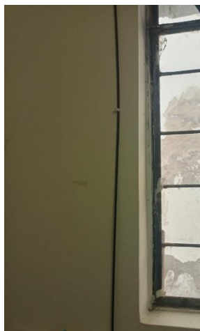
Imagen 14. Grapado de cable en el interior del domicilio
