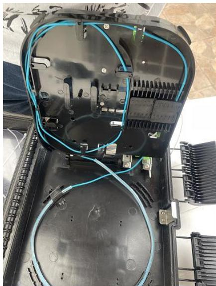
Una vez medido el buffer, corte el excedente de fibra óptica.
