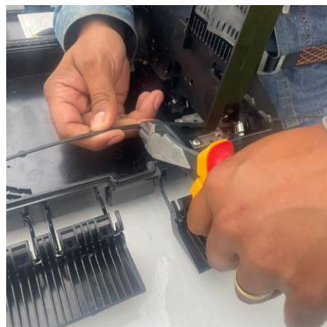
Separe el mensajero de la fibra drop y coloque 5 cm en el herraje de sujeción, ajuste el tornillo con la ayuda de un destornillador.
