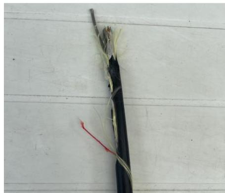
Con mucho cuidado tire de la guía de corte, hasta la señal circular realizada a 1.5m de la punta.
