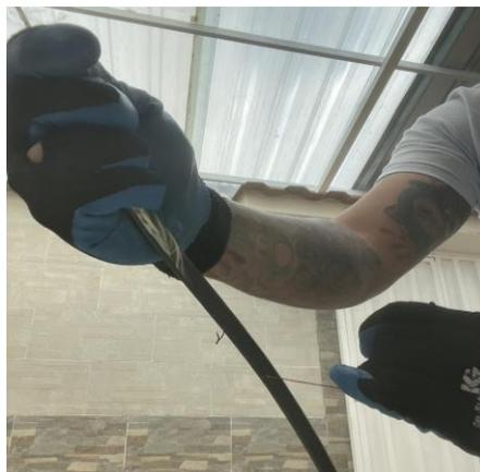
La guía de corte se debe apreciar de la siguiente manera, terminando el desforre justo en la señal realizada.
