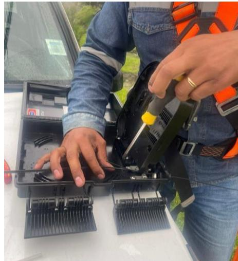
Doble el mensajero para mayor agarre del cable. Coloque el tubo de protección como se aprecia en la figura 2 y sujétela con una amarra de 10 cm.
