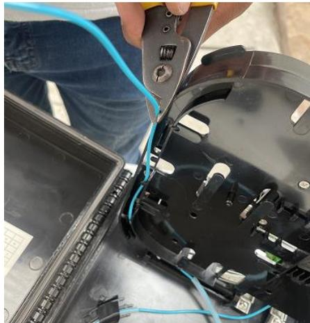
Con mucho cuidado retire la chaqueta del buffer, halando de forma direccional sosteniendo ambos extremos donde se realizó el corte con la pinza peladora de cable.
