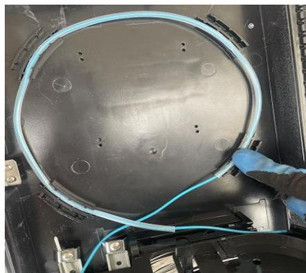
Con la ayuda de una amarra y cinta aislante, sujete el buffer a la bandeja de distribución delantera de la NAP.
