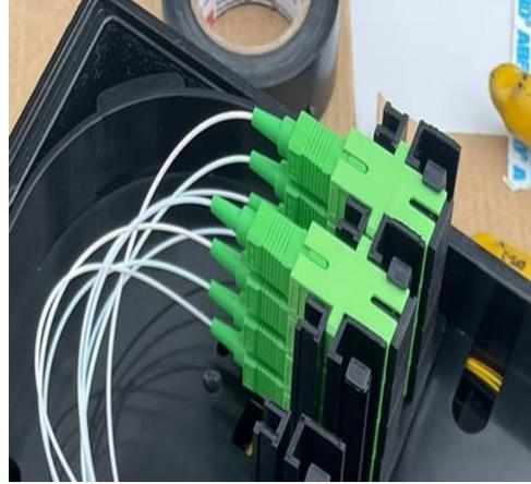
Organice el excedente del divisor óptico en la bandeja inferior de la NAP, haciendo uso de las cejillas de soporte. Ayúdese con amarras de 10cm respetando los ángulos de curvatura de la fibra óptica.
