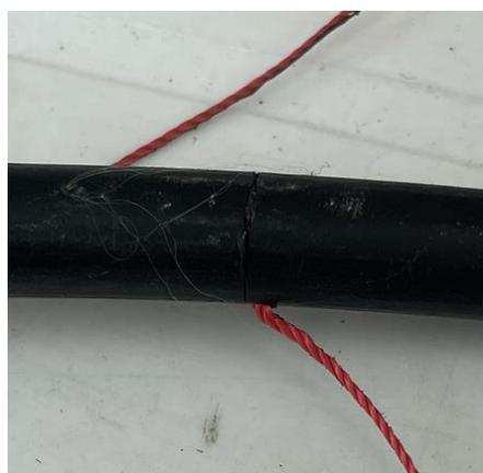
Separe el núcleo del cable de fibra óptica de la chaqueta externa con mucho cuidado evitando doblar los buffers.
