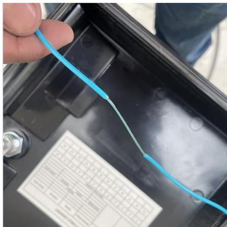
Humedezca la toalla anti-pelusa con alcohol isopropílico y proceda a retirar el gel de los hilos de fibra hasta dejar sin rastro del mismo.
