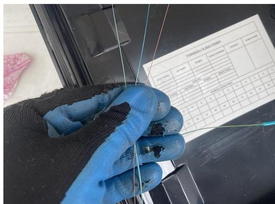
Por seguridad volvemos a colocar los hilos en la bandeja para poder colocar el splitter en la parte delantera de la bandeja.
