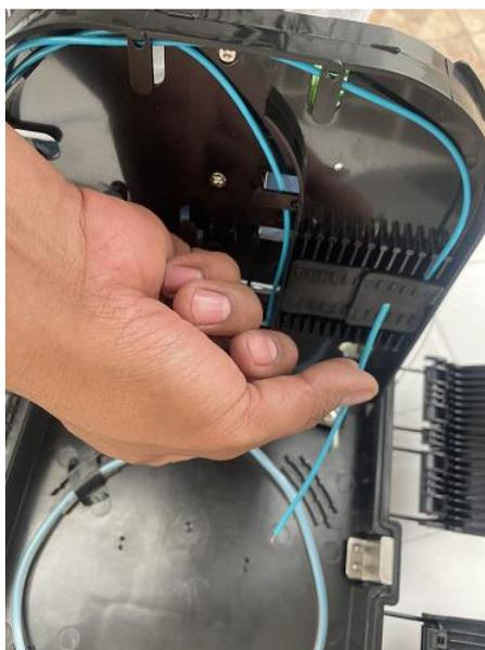
Retire el buffer de la bandeja para poder manipular y proceder con la extracción de los hilos de fibra óptica. Realice el corte con la ayuda de la peladora de cable (orificio 3 más grueso) en la distancia conveniente dependiendo de la caja NAP. En este caso en el canal de ingreso de la bandeja.
