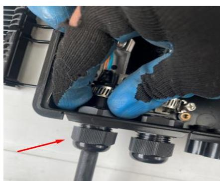
Coloque el tubo de protección sobre el buffer de la fibra como se aprecia en la imagen.
