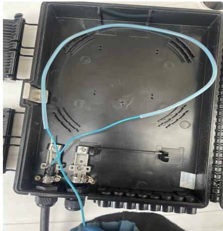
Ubique el buffer por las cejillas de sujeción de la caja NAP, y guíe el buffer de derecha a izquierda para evitar daños al momento de cerrar la bandeja.
