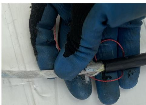
Para facilitar el descubrimiento de los hilos de protección, realice dos cortes, al inicio y en medio de la zona descubierta de la fibra, así el retiro del par trenzado será mucho más rápido y eficiente.
